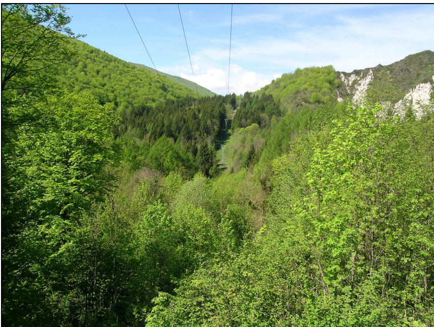
Neoformazione forestale nell'area sottesa all'elettrodotto
